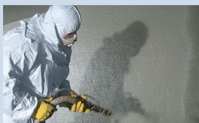
Spritzapplikation Deckschicht
