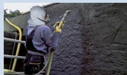
Spritzapplikation Ausgleichsschicht
